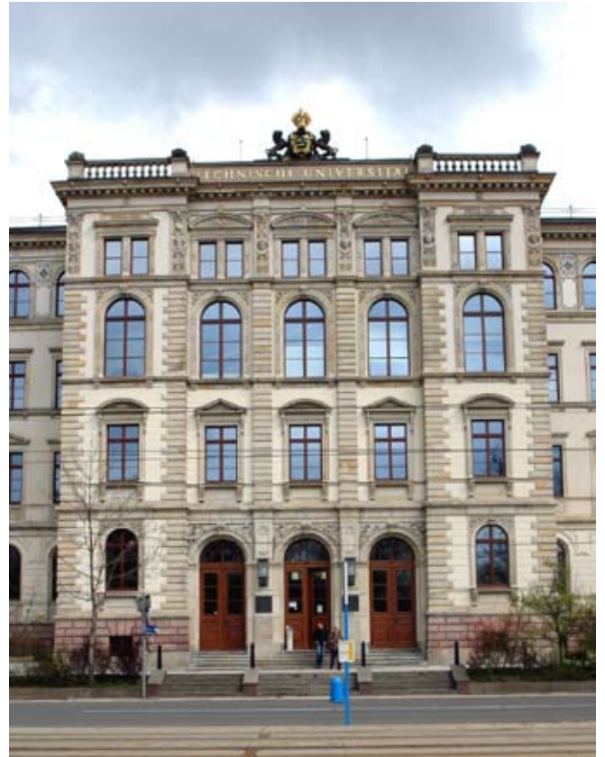
Abb. 43 Hauptgebäude TU Chemnitz
